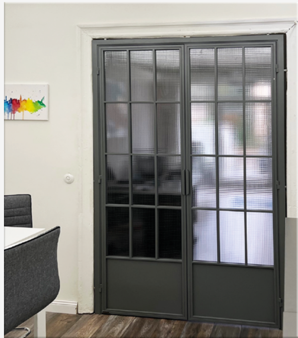
Drehtür 2-flg. in vorhandene Altbau-Zarge verbaut
